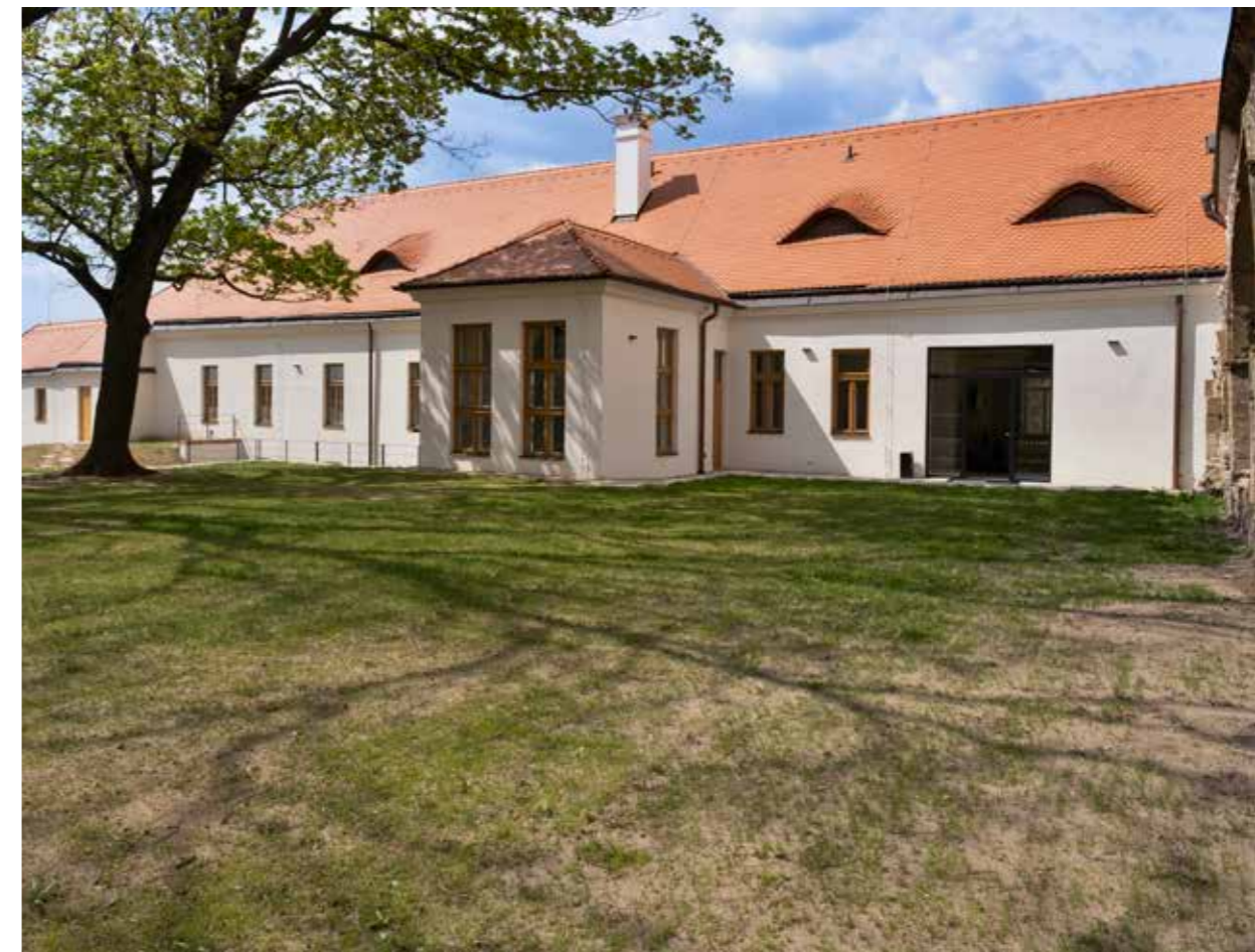
EÚS — Centrum obnovy společného kulturního dědictví — objekt Staré školy v areálu Louckého kláštera ve Znojmě, Jihomoravský kraj
