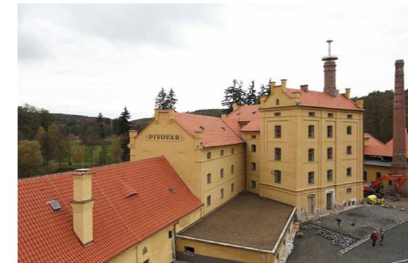
IOP – Projekt „Centrum stavitelského dědictví“ zahrnoval rekonstrukci areálu pivovaru v Plzeňi a byl jedním z velmi úspěšných projektů programu IOP. Fotografie: Lukáš Jasanský
