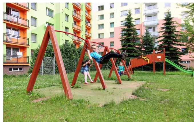
▣ V novém období bude kladen větší důraz na využití integrovaných přístupů. V tomto období byly aplikovány pilotní integrované přístupy v městských sídlištích, včetně náchodského sídliště u nemocnice. Autor: Ing. Jiří Šlemar
