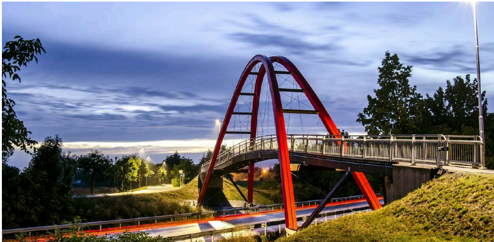
Hořice - lávka přes silnici I/35
