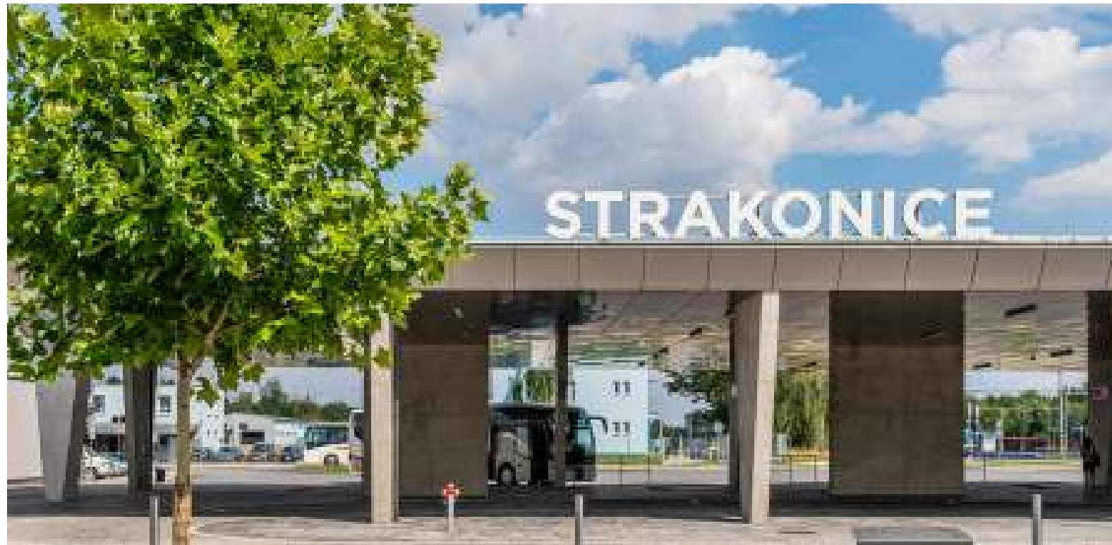
Dopravní terminál Strakonice
