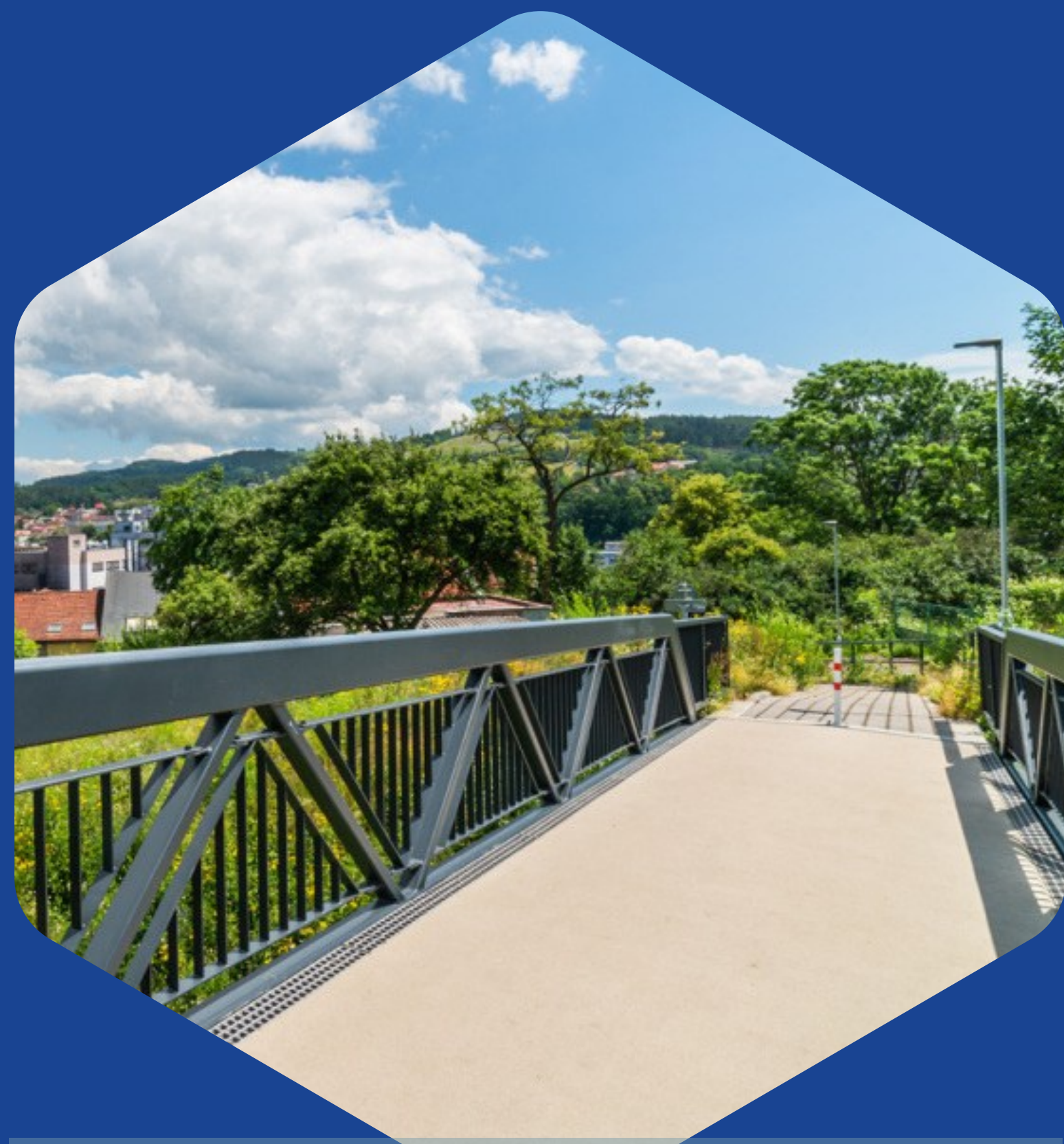
Lávka přes železniční trať, Náchod Příjemce: Náchod, dotace EU: 1,1 mil. Kč, IROP 1
