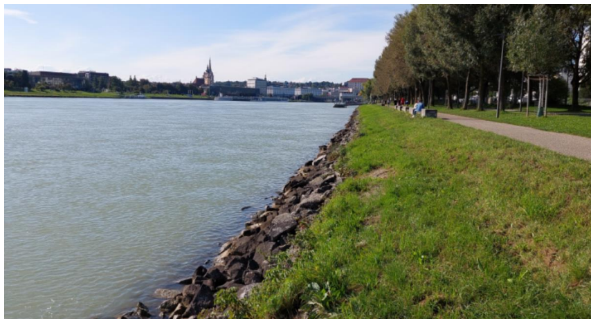
původní stav – opevnění
