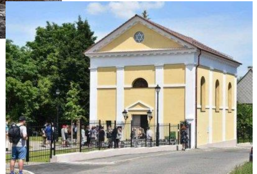
Foto: před a po rekonstrukci
